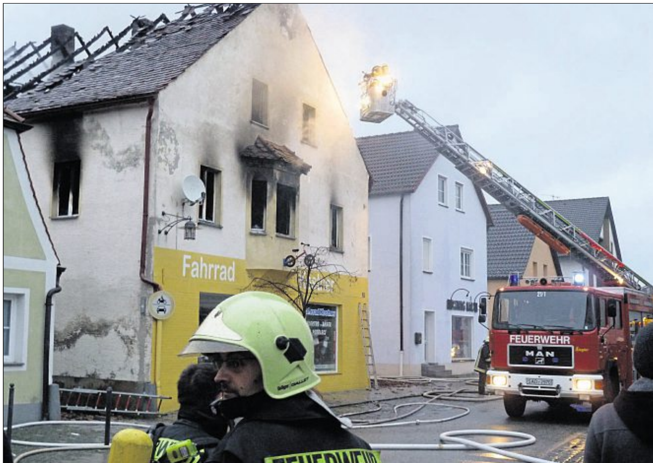
Das Feuer machte das Haus unbewohnbar. Der erste Stock und der Dachraum brannten vollständig aus. Auch das Geschäft im Erdgeschoss blieb von den Folgen des Brandes nicht verschont. Bilder: Amann (2)
