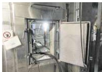
► **Einstieg:** Alle Einsatzkräfte mussten durch eine 50 mal 70 Zentimeter kleine Lucke in 29 Meter Höhe in den Feuerraum einsteigen, was Anforderungen an die Hilfs- und Rettungskräfte stellte.
